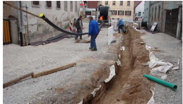
Abb. 30: Offener Rohrgraben und Abwickelvorrichtung
