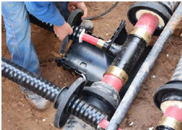
Abb. 4: Montage HeatClick Muffe im Bestand (Muffendichtgummi)
