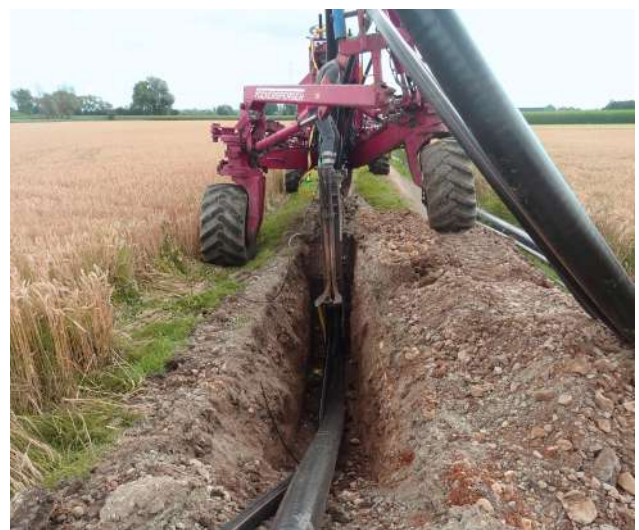
Abb. 27: Pflugverlegung
