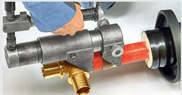
Schiebehülse über Stützkörper ziehen. Die Verbindung ist in Ordnung, wenn das Mediumrohr den letzten Steg am Stützkörper überdeckt.
