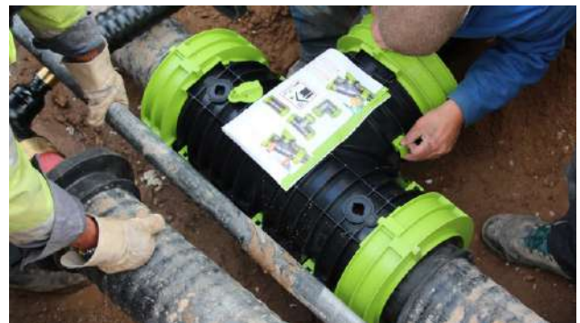
Abb. 5: Montage HeatClick Muffe im Bestand (Einsteckclip)
