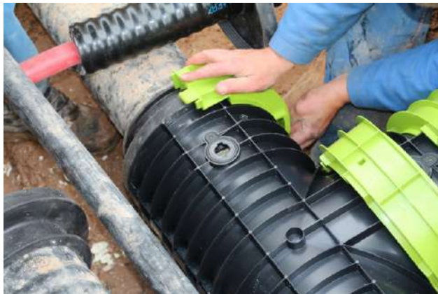
Abb. 3: Montage HeatClick Muffe im Bestand (Verschlussring)
