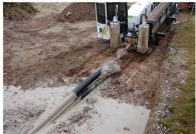
Abb. 29: Spülbohrgerät mit Rohren in der Startgrube
