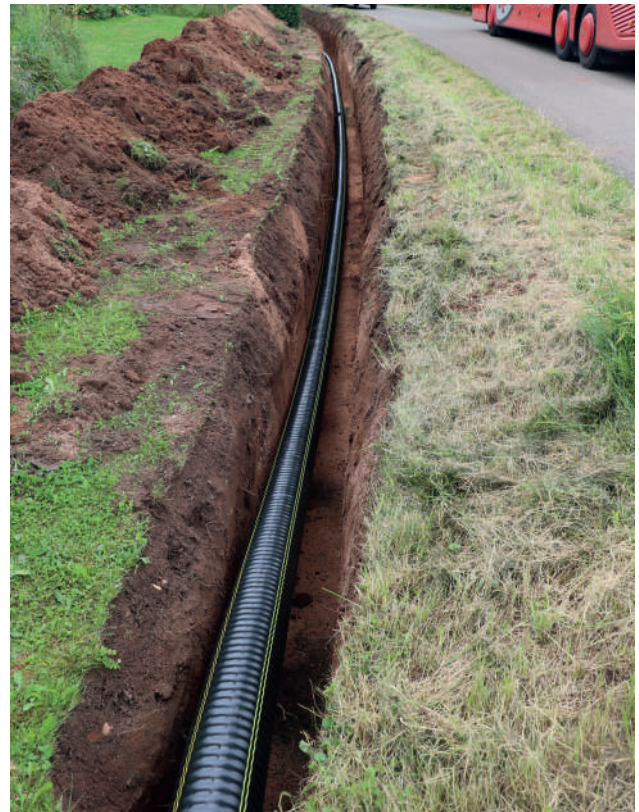
Abb. 2: Verlegung in der Praxis
